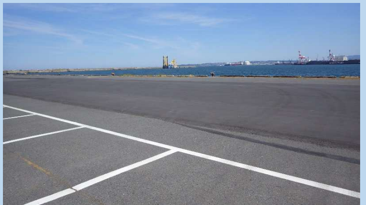
令和8年6月1日 現場の状況（仮復旧後）
