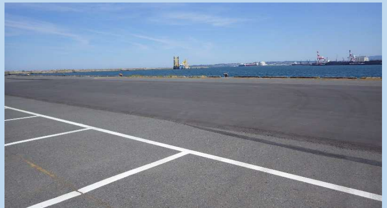
令和8年6月1日 現場の状況（仮復旧後）
