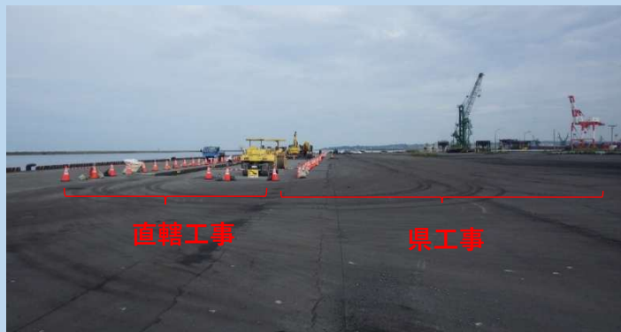
令和8年7月21日 現場の状況
