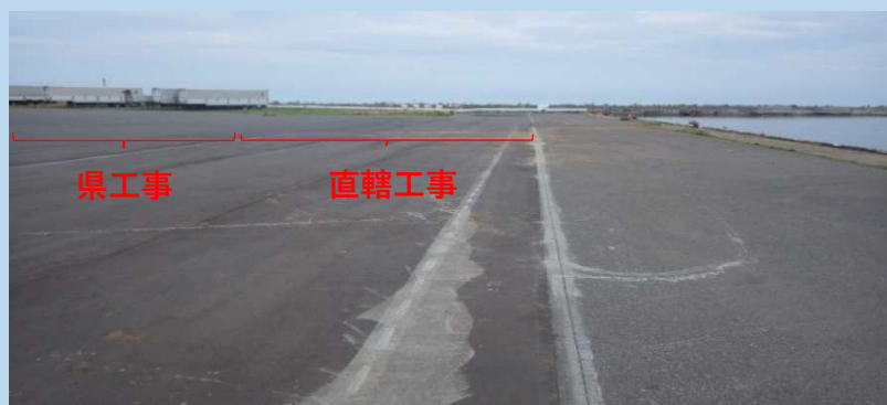
令和8年7月21日 現場の状況
