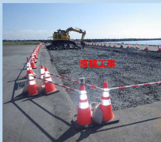
令和8年8月21日 現場の状況
