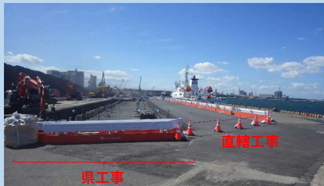
令和8年8月28日 現場の状況
