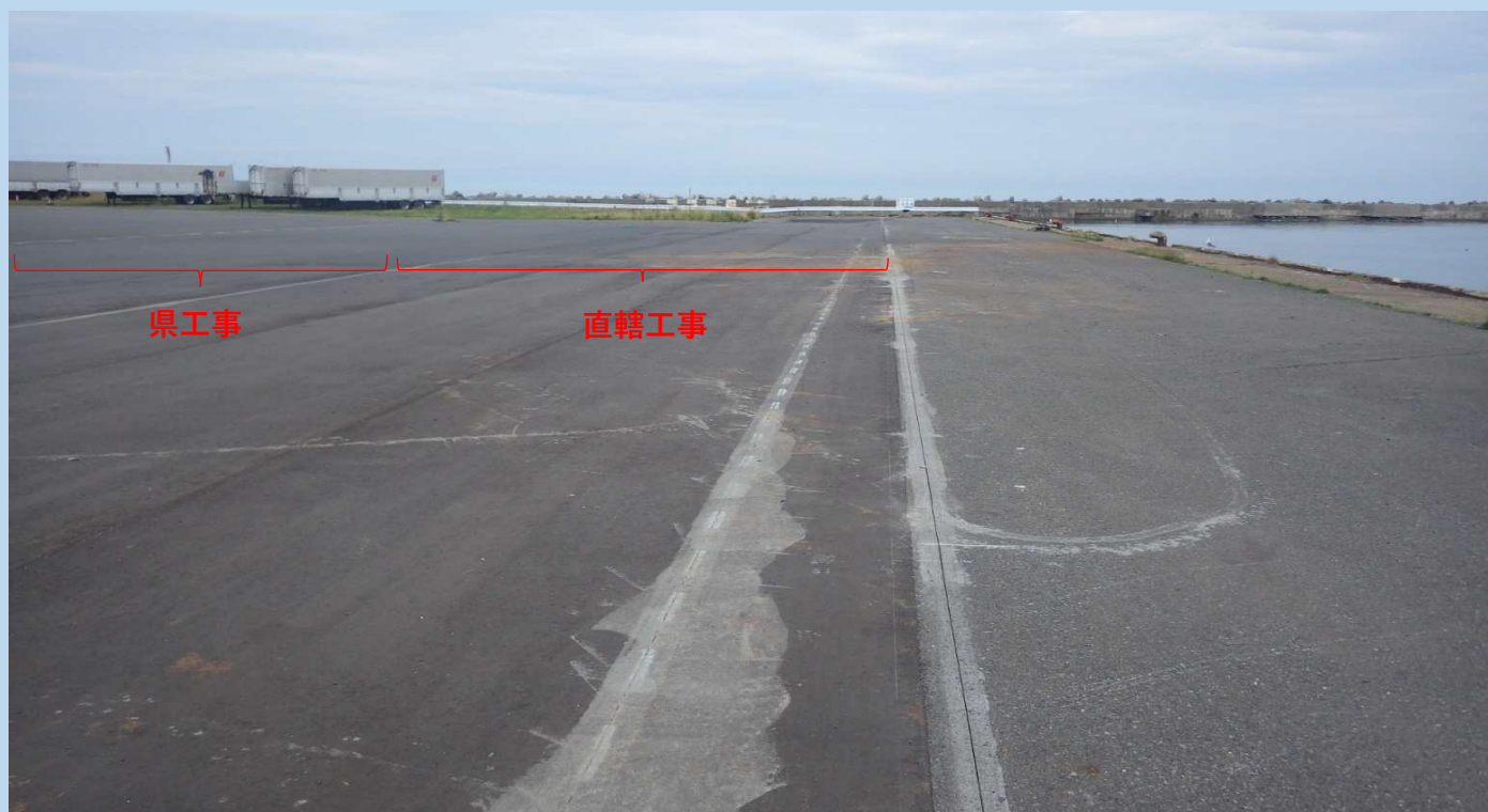
令和 8 年 7 月 2 1 日 現場の状況
