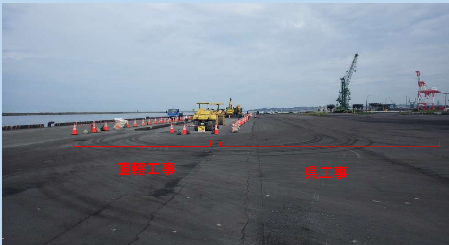
令和 8 年 7 月 2 1 日 現場の状況
