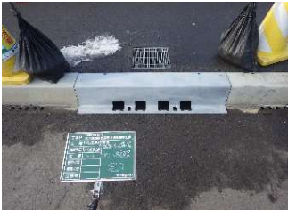
加工蓋設置完了
