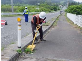
清掃工（土砂撤去）
