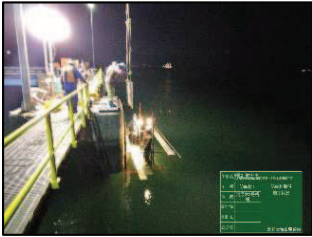
夜間（干潮）作業
