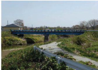
轟木橋 側面全景
