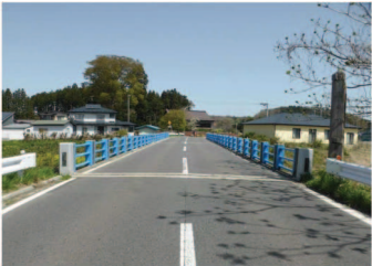
轟木橋 正面全景
