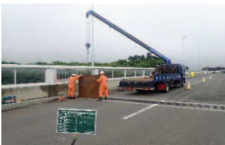
車線規制～敷鉄板布設 桔梗橋 伸縮装置の緊急措置
