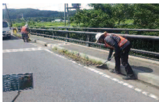
清掃工（土砂撤去）
