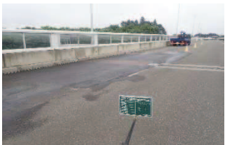
車線規制～敷鉄板布設 桔梗橋 伸縮装置の緊急措置
