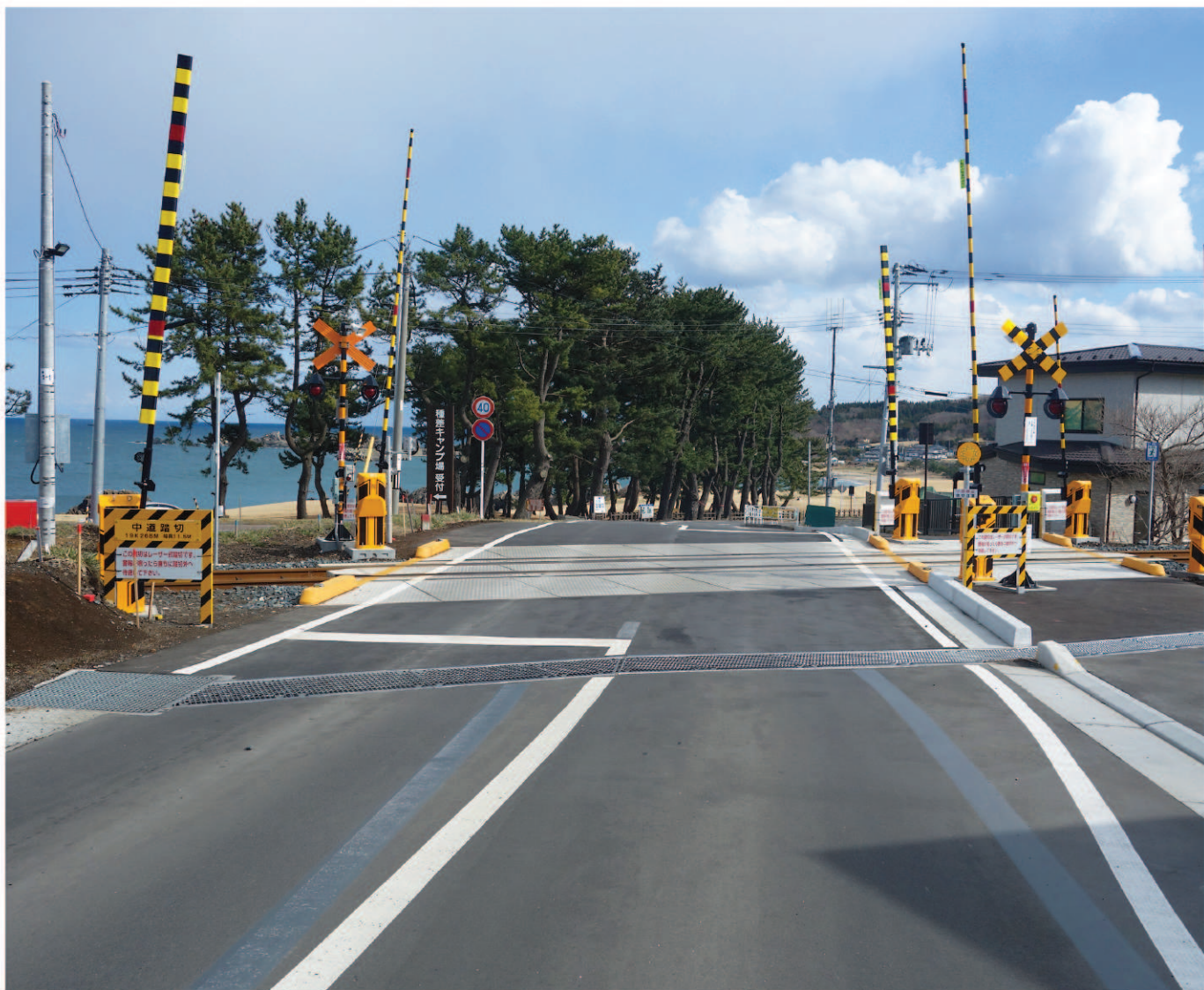
八戸階上線 交通安全施設整備事業
