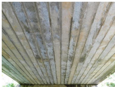
写真-1 釜屋沢橋桁下全景
