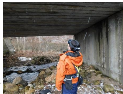
写真-4 塩素濃度の投影状況
