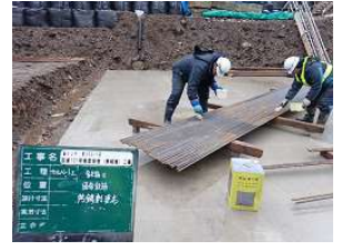
【通常鉄筋の防錆対策】
