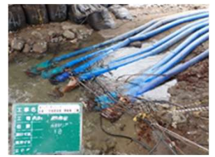
【通常鉄筋の防錆対策】
