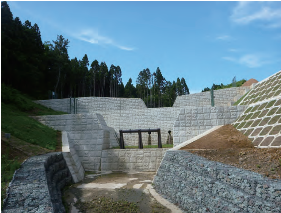
平成25年完成 吉花沢2号堰堤(深浦町)
