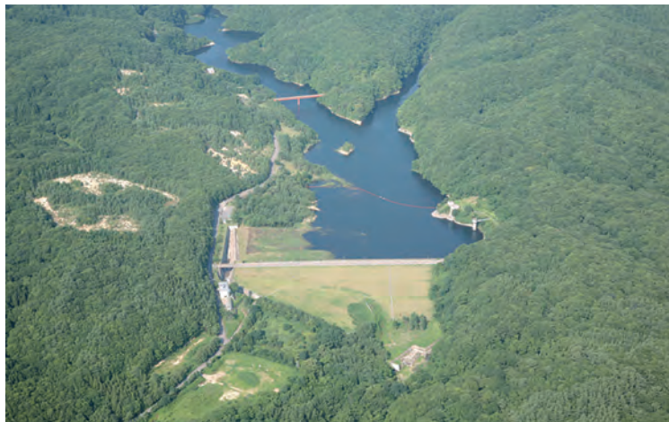
飯詰ダム（五所川原市）
