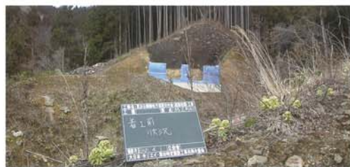
着工前(平成21年4月)
