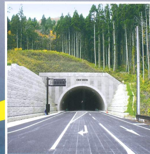
白糠側トンネル坑口
