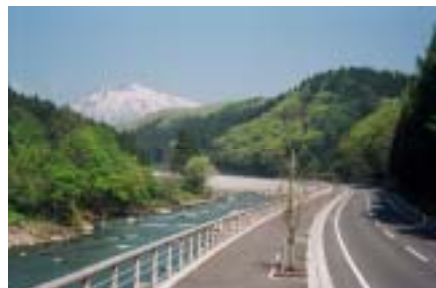
完成後(国吉～湯口工区):幅員確保、急カーブ解消 現在、藤川～田代工区実施中
