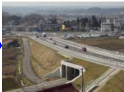
完成後(期工区):急勾配解消により渋滞緩和 現在 期工区実施中
