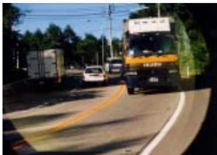
現道:急勾配、急カーブによる走行速度低下
