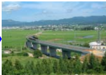
バイパス工事実施中 (青森空港側より青森市内を望む) H17完成予定
