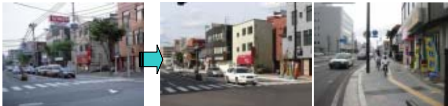
弘前鯉ヶ沢線 代官町工区 (電線地中化)
