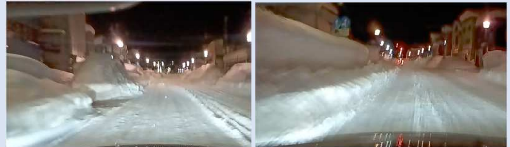
車道部、歩道部双方からの寄せ雪により堆雪スペースが狭くなっている状況 （令和8年2月3日）
