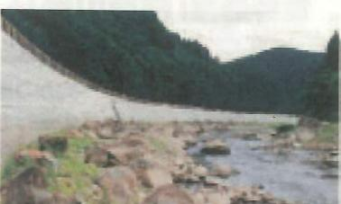
河川部には、大型モタレ式擁壁に化粧型枠を用いて、周辺景観と調和がとれるように記述します。（実施例）
