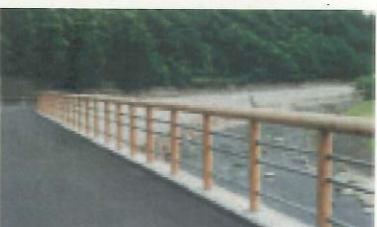
道路の歩道側に設置されている転落防止柵に地元産ヒバ材（間伐材）を使用します。
