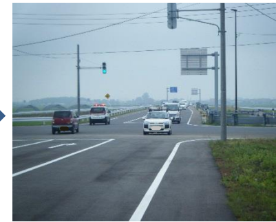
整備後(バイパス供用状況)
