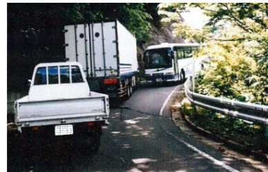
整備前(現道状況)
