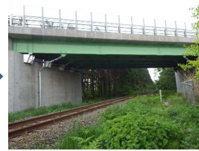
施工後 (塗装塗替、耐震対策etc)
