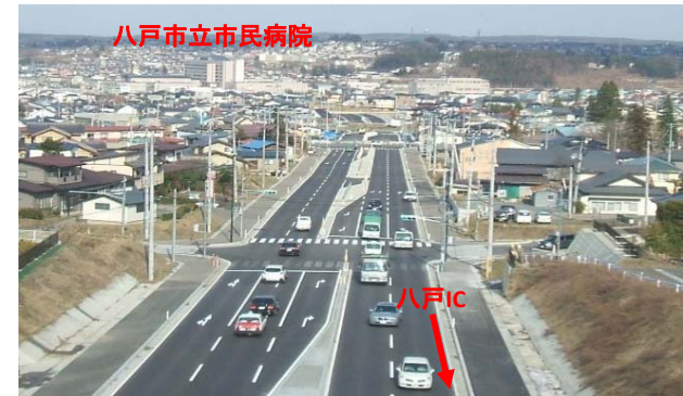
バイパス供用状況
