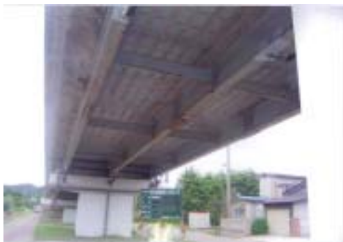
夏泊公園線 白鳥大橋 【塗装塗替前】
