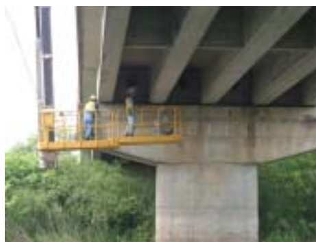
下田停車場線 下田橋
