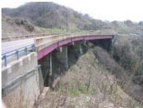
国道101号 木蓮寺陸橋 【補修前】
