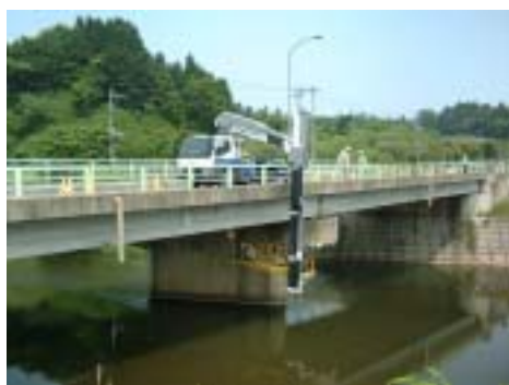
水喰上北町停車場線 鳥口橋
