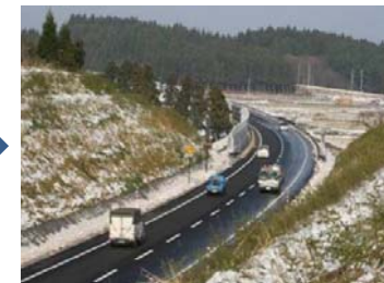
整備後(バイパス供用状況)
