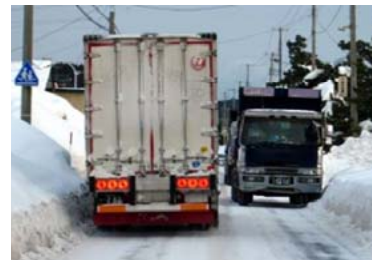
整備前(現道状況)
