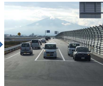
整備後(バイパス供用状況)
