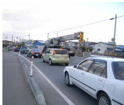
整備前(現道状況)
