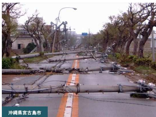
災害時の電柱倒壊に伴う通行不能状況
