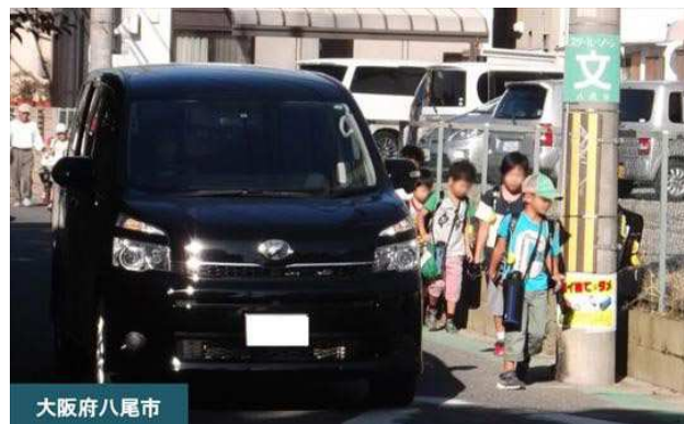
電柱による歩行者・自転車の通行支障状況
