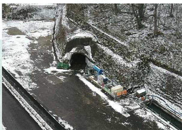
トンネル終点側
