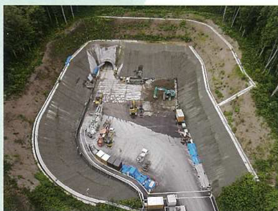
トンネル起点側
