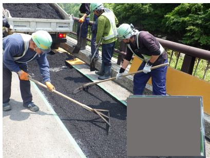
欠損部補修
