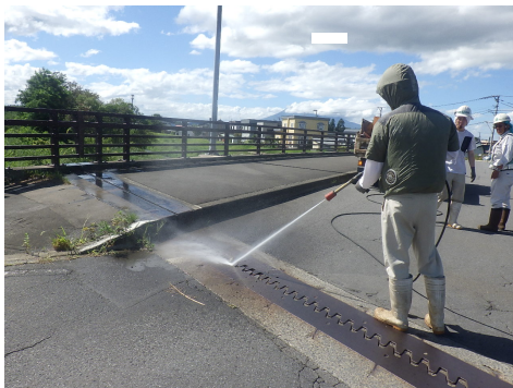
伸縮装置清掃
