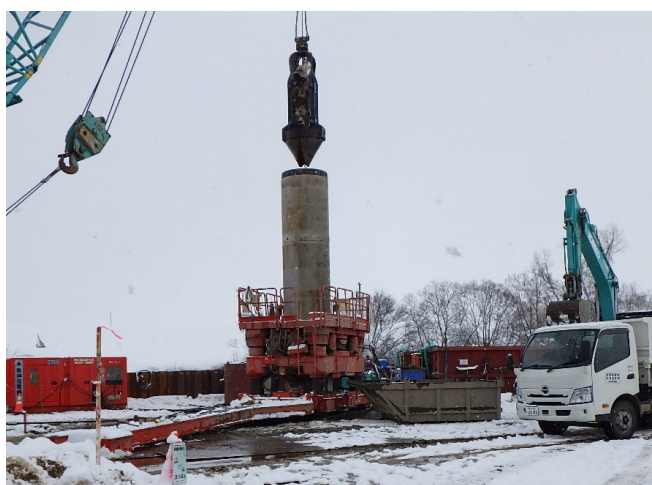
前坂藤崎線 藤崎橋 橋脚基礎施工状況
