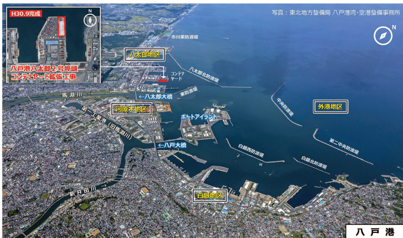
図4-9 八戸港コンテナヤード拡張
