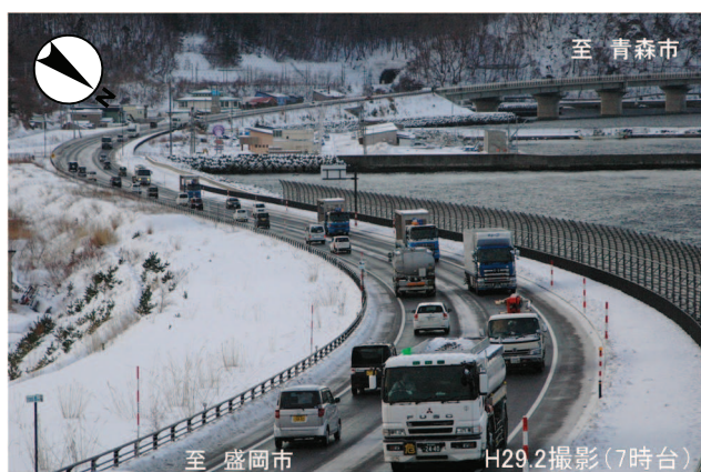
▲国道4号土屋バイパス
