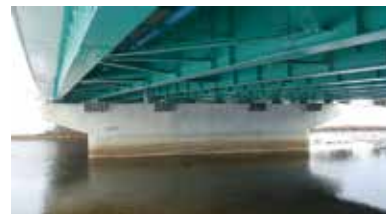
▲ 橋梁補修（補修・耐震補強） 主要地方道 青森環状野内線 荒川橋
