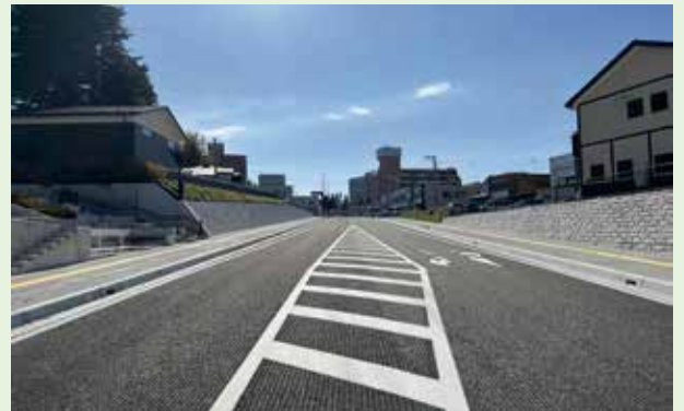
八戸都市計画道路3・5・1号沼館三日町線 (令和4年12月部分供用)
