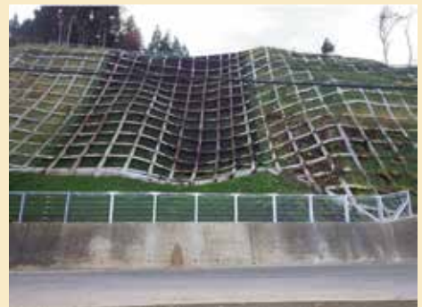
施工後(対策完了)
