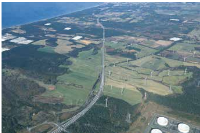
下北半島縦貫道路 吹越バイパス
