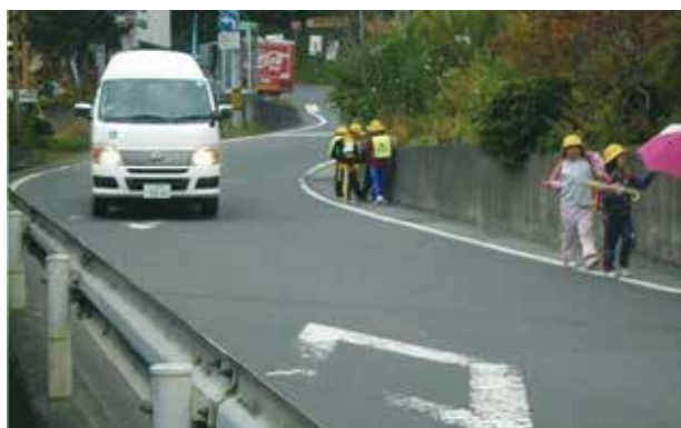
歩道の未整備区間 (国道454号 新郷村)
