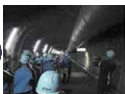
トンネル工事見学
