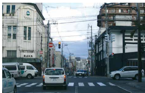
電線類の錯綜 (主要地方道弘前岳鱒ヶ沢線 弘前市)
