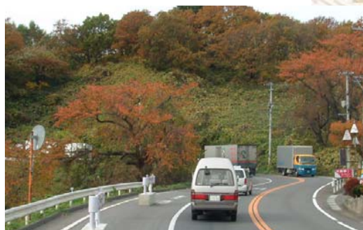
現道: 急勾配、急カーブによる走行速度低下
