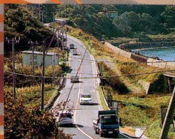
●安全走行を困難にしている急勾配と急カーブが続く。
