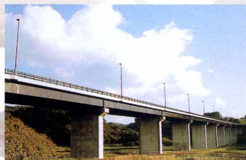
●追良瀬バイパス「夕陽海岸大橋」
