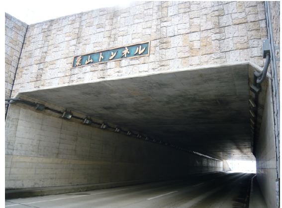
国道338号 栗山トンネル
