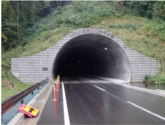
夏泊公園線 夏泊ほたて海道トンネル
