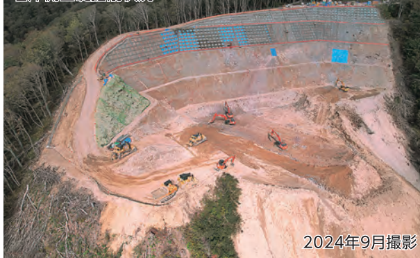
右岸側基礎掘削状況
