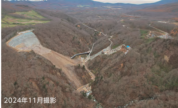
ダムサイト全景
