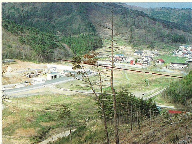
平成8年5月 ダム本体着工前
