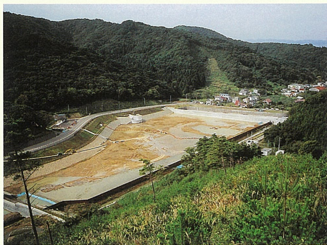
平成13年10月 ダム本体工事完成
