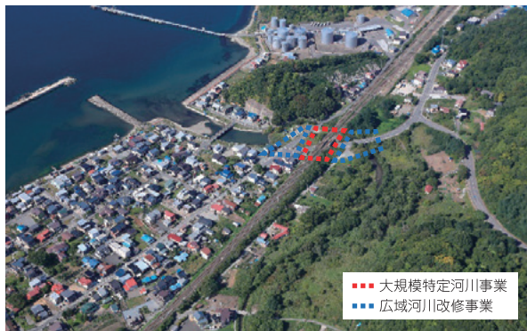
貴船川大規模特定河川事業、貴船川広域河川改修事業
