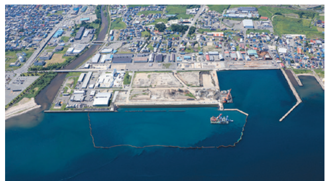
青森港油川地区（ふ頭用地造成事業）
