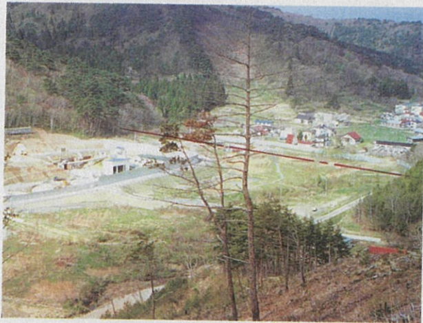
平成8年5月 ダム本体着工前
