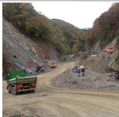
掘削状況（河床部）
