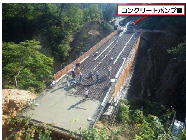
写真-2 床版コンクリート打設状況
