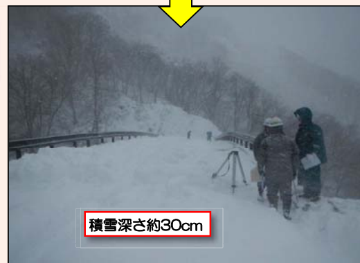
完成検査時状況（平成28年11月25日）
