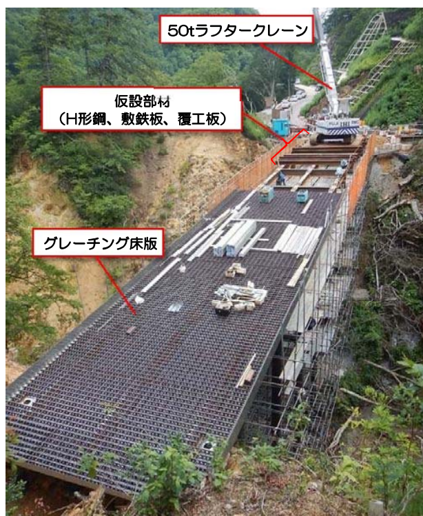
写真-1 グレーチング床版設置状況
