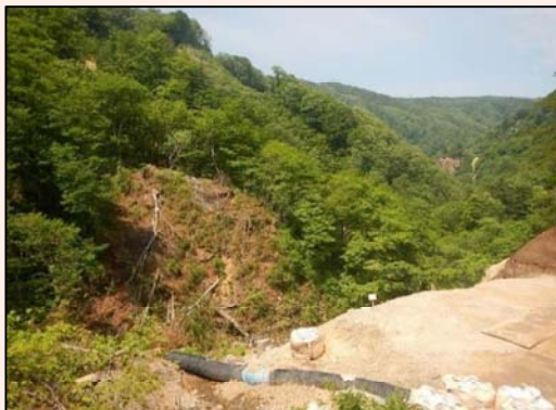
着工前（平成28年5月30日）
