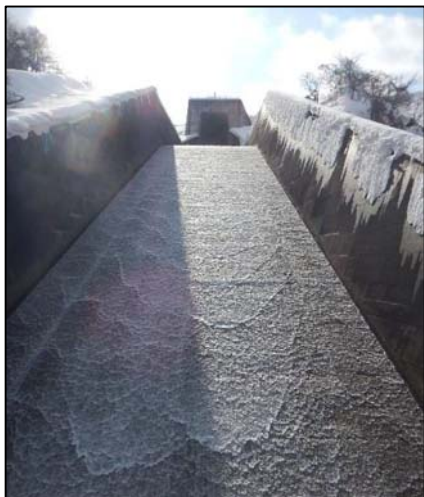
厳冬期の晴れ間と下湯ダム洪水吐（下流側より）
