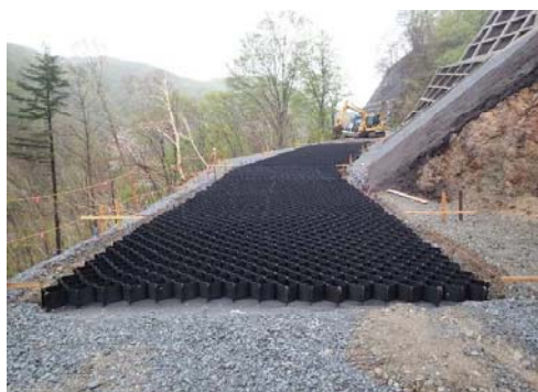
写真② ジオセル路盤工（ジオセル：高密度ポリエチレンで出来たに加状の軽量型枠）
