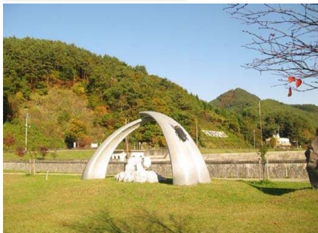
浅虫ダム～下流側より～
