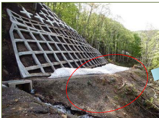
着工前（②工事：1号工事用道路）
