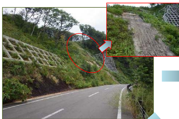
着工前（⑥工事：4号工事用道路）
