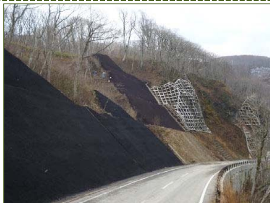
連続繊維補強土完成状況その1
