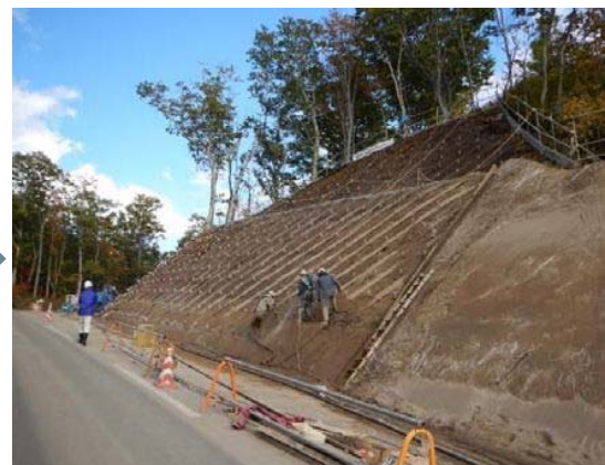
法面保護状況（連続繊維補強土工法：⑥工事）
