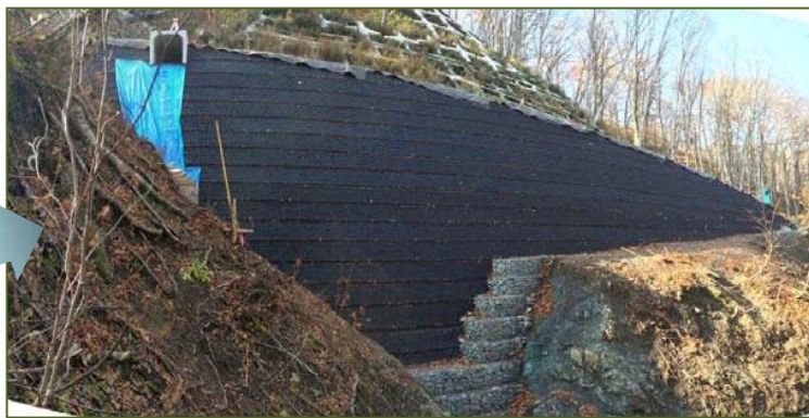
補強土壁完成状況
