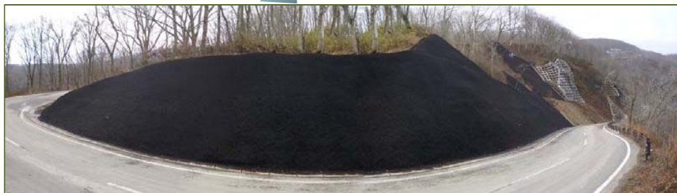
連続繊維補強土完成状況その2
