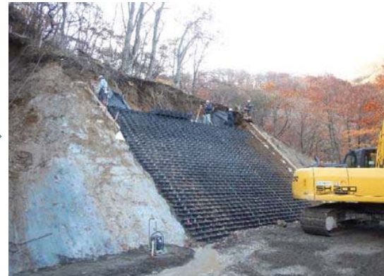
法面保護状況（テラセル擁壁工法：①工事）
