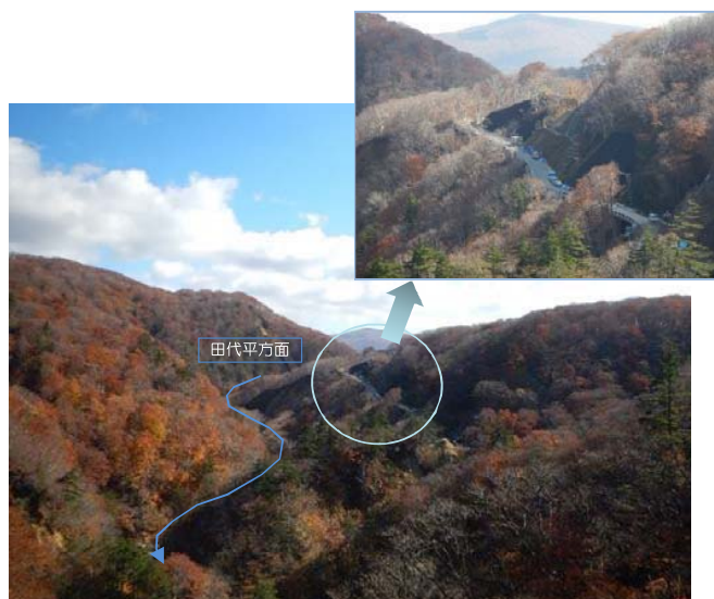
4号工事用道路工事箇所周辺
