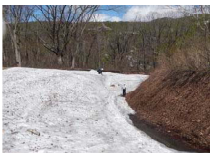
写真-5 3号工事用道路
