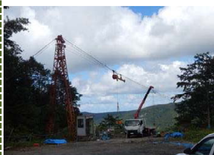
資機材運搬状況 （索道を利用して、右岸の調査箇所へと資機材を運搬しています）
