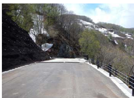
写真-6 4号工事用道路
