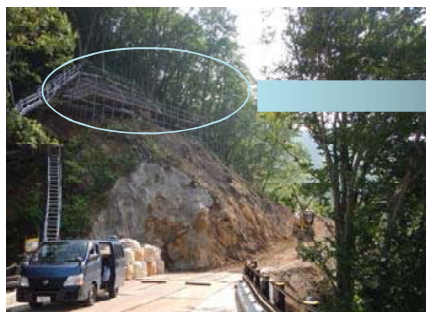
法面掘削状況（7/29現在）
