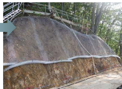
アンカー1段階目法面状況 （赤十字スプレーはアンカー位置）
