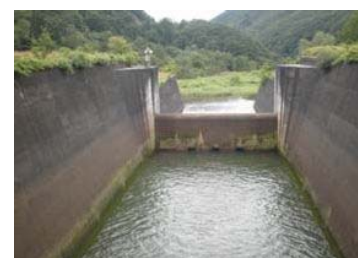
下流放流状況（平常時）
