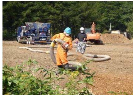
チップ吹付状況 （パークブロー工法）
