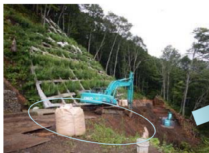
掘削状況（8/25現在）
