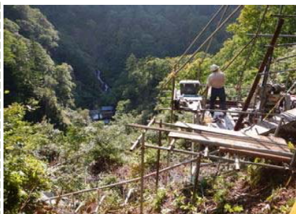
ボーリング調査状況 （急峻な斜面に足場を作ってボーリングの作業をしています）
