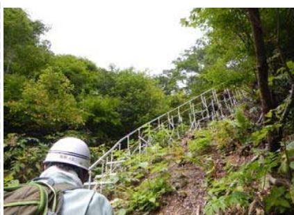
モノレール架設状況 （急峻な斜面をモノレールで運搬・移動しています）
