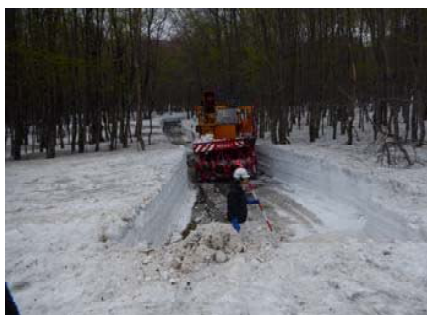
写真-1 進入路除雪状況
