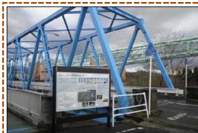
駒込橋の筒井側
