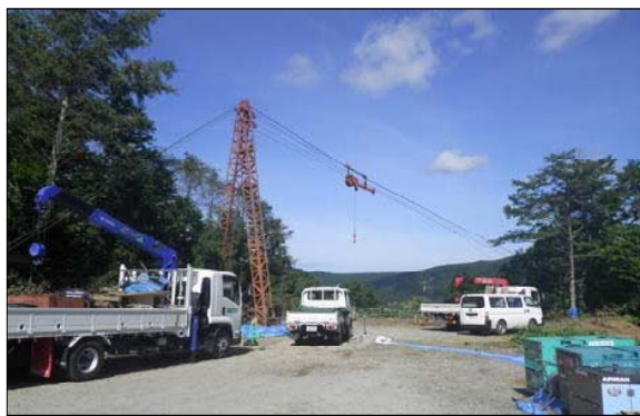
（上写真）発電機を右岸に向けて吊りあげています。
