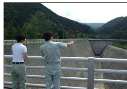
下湯ダム洪水吐の見学
