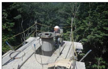
杭頭溶接状況
