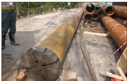
ダウンザホールハンマー
