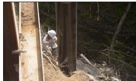
モルタル注入状況
