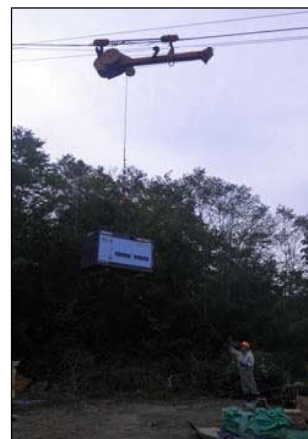
（上写真）発電機を右岸に向けて吊りあげています。
