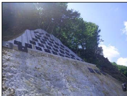
法面工の実施状況
