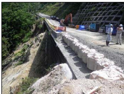
補強土壁工の実施状況
