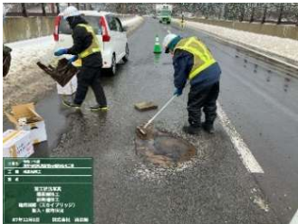
舗装補修状況
