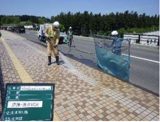
路面清掃状況
