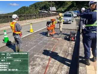
床版損傷度調査
