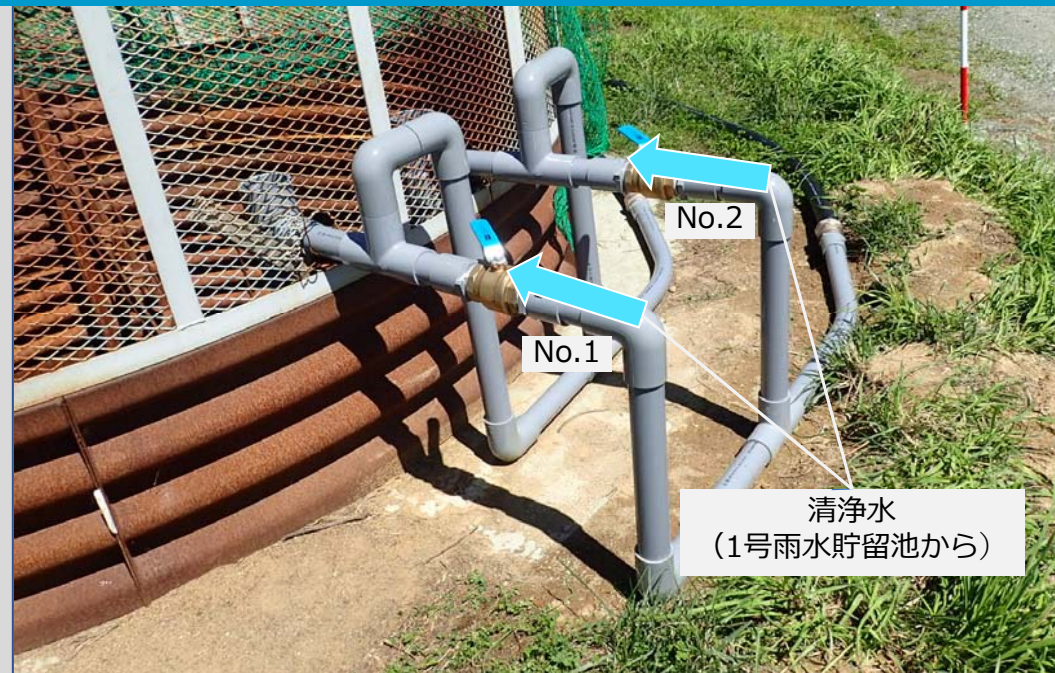
注水用横ボーリング R 3.8.19より注水開始
