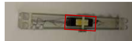
蛍光灯安定器の例(反射板を外した状態)
