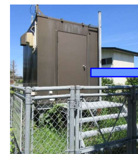
常時監視測定局の外観
