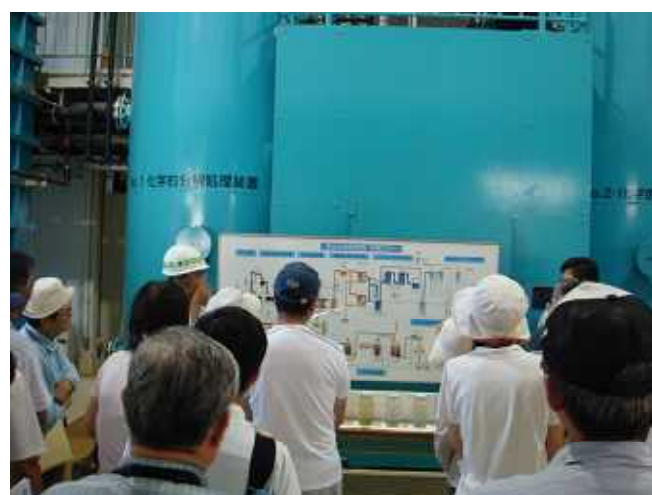
浸出水処理施設の見学
