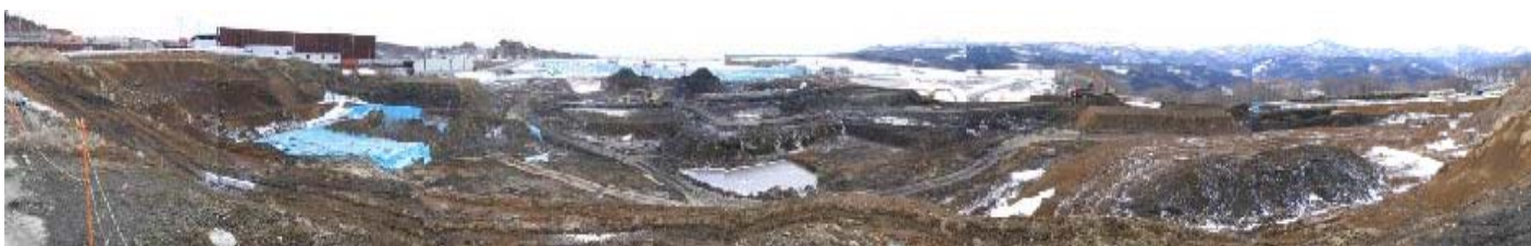
選別ヤード側から見た現場の全景 (平成22年3月9日撮影)
