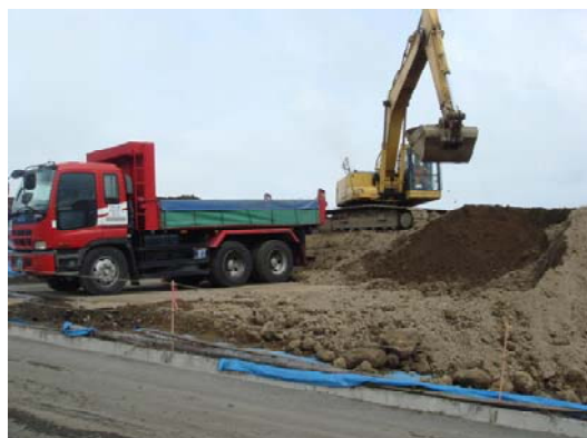
汚染土壌搬出の様子(7月6日)
